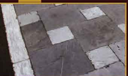
Pierre bleue rustique
